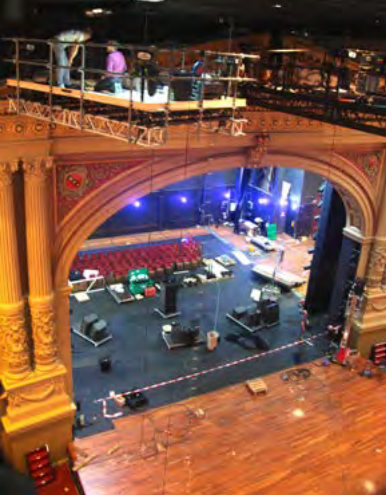
Montage van het railsysteem en de speakers
