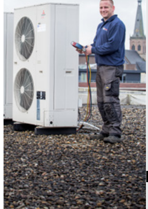
De klimaatinstallatie bij Ortho Doetinchem is weggewerkt in houten panelen
